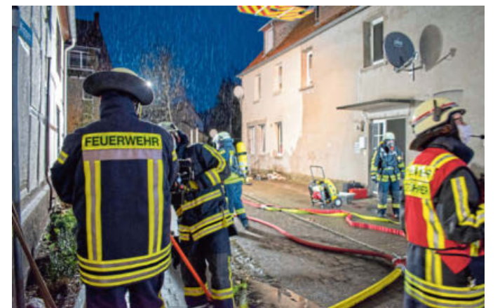
Das Haus in der Horner Altstadt ist nach dem Küchenbrand derzeit nicht bewohnbar. FOTO: FEUERWEHR HORN-BAD MEINBERG
